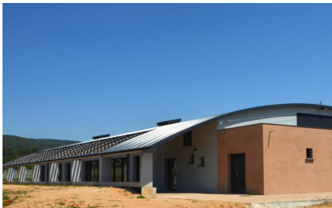
Salle des Restoubles Avenue du Docteur Bosio
