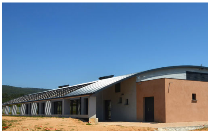
Salle des Restoubles Avenue du Docteur Bosio
