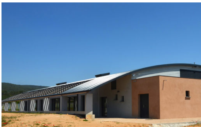
Salle des Restoubles Avenue du Docteur Bosio
